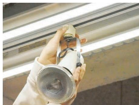
③親指でロックを下げながら本体を時計方向に約90度回して取り付けます。落下の危険がありますのでしっかり取り付けてください。
